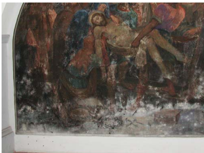
Fot. 6. Krużganki odpustowe przy kościele pw. Wniebowzięcia NMP w Kcyni, Stacja XIV z widocznymi nawiertami pomiarowymi poniżej malowidła ściennego (fot. Solida Lim)
